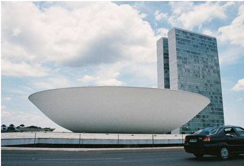
Figura 7: Ambiente predileto do Seu Creysson. (A imagem está reduzida).
